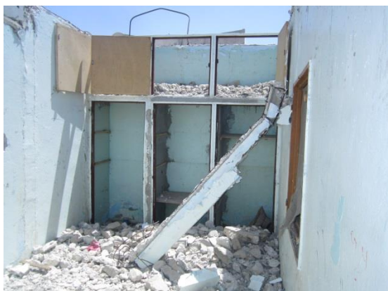
Kuva 2 Katto on romautettu alas, ja alkamassa on uuden katon rakennustyöt.
