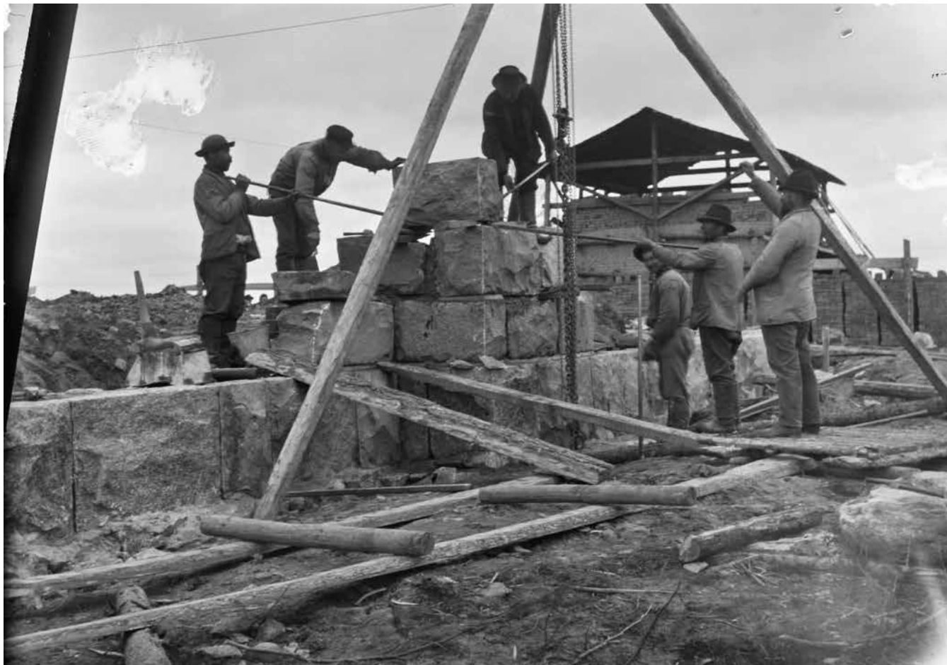
Stenbäckin ottama kuva Vuolijoen kirkon työmaalta todennäköisesti kesällä 1905. Siinä näkyy kuinka asetteluvaiheessa käytettiin tukena puukiiloja. Kun kivi oli saatu asemaansa, se tuettiin kivikiiloilla ja saumat täytettiin laastilla - niin hyvin kuin pystyttiin. Oikealla työnjohtaja katsoo luotilangalla, että nurkka tulee pystyvuoraan. Pieni seinäosuus on todennäköisesti tehty malliksi arkkitehdin ollessa työmaalla. Taustalla näkyy myös tiiliuuni ja valmiita tiiliä pinottuina. Kuva: Josef Stenbäck, 1905, Historian kuvakokoelma, MV.
