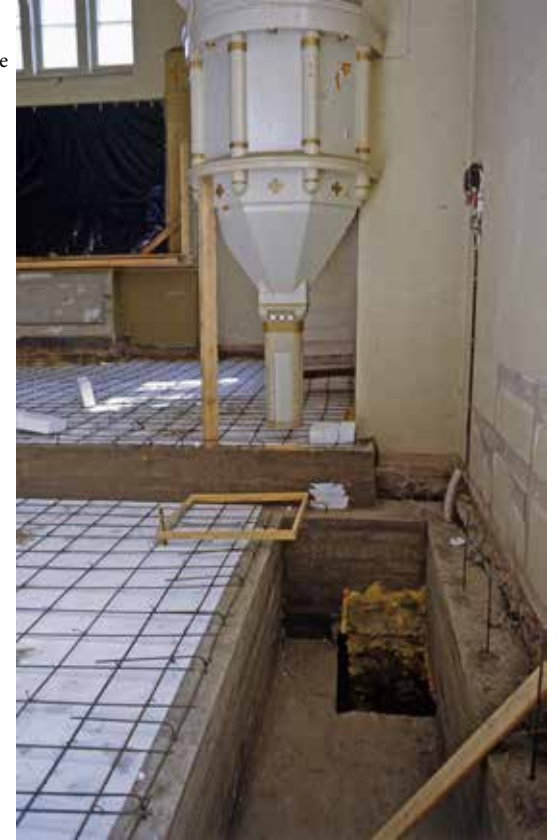
Saarnatuolin jalan oikealla puolella näkyy poistetun ilmalämmityskanavan betoninen pystykanaali.
