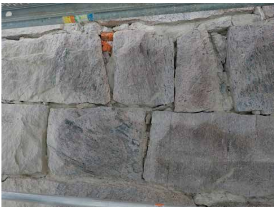
Puhdistettuja saumoja. Kivien syväsaumauksia ei uusittu, vaan pelkästään pahiten vaurioituneet pintasaumaukset.
