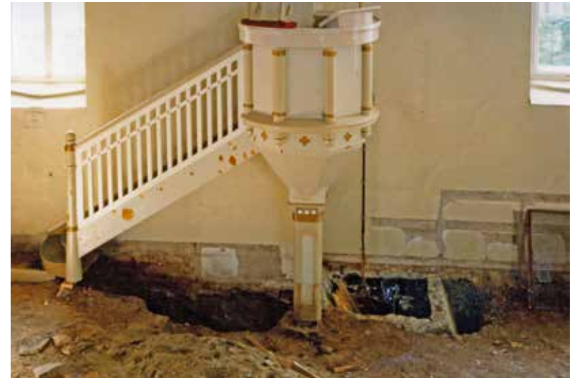
Saarnatuolin jalan oikealla puolella näkyy poistetun ilmalämmityskanavan betoninen pystykanaali.
