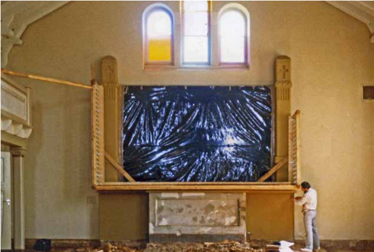
Altarikaide on nostettu talteen alttarin päälle seinää vasten. Alttaritaulu on suojattu mustalla muovilla.
