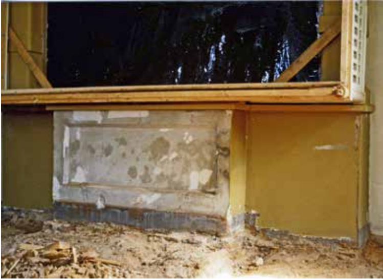
Alttaripöydän etupinnassa näkyy oletettavasti kirkon alkuperäinen vaaleanharmaa seinäväri. Tämän sivun kaikki kuvat: Asko Karttunen.
