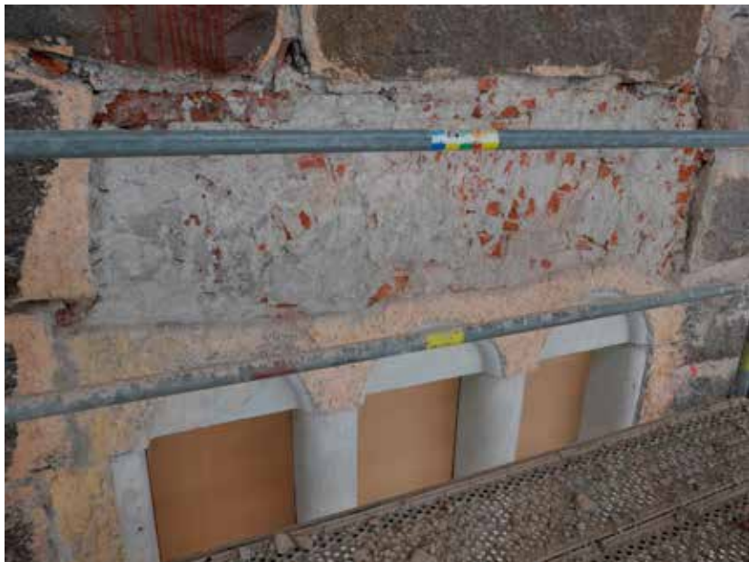
Ikkunoiden yläpuolet on tehty kokonaan tiilestä muuraamalla.
