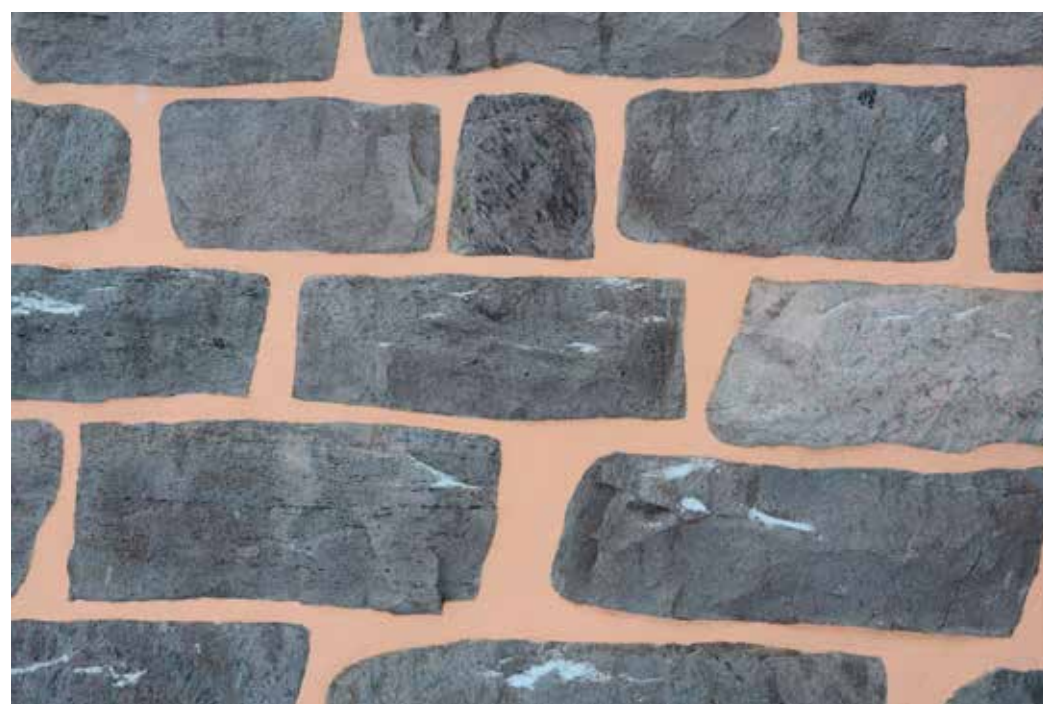
Valmista saumattua kiviseinää.
