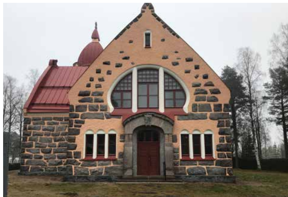
Ylempänä kuvan ennen julkisivukorjausta ja alempana kuva korjauksen jälkeen.
