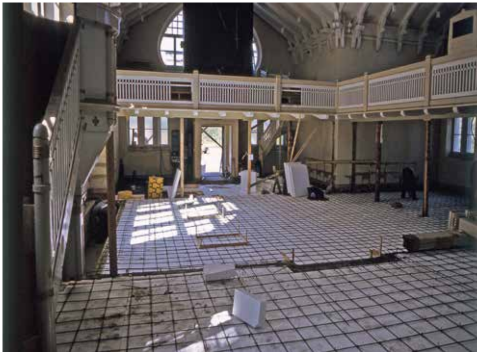
Vanha alapohja on purettu. Maanpintaa madallettu ja asennettu EPS-eristeet sekä teräsverkko. Tämän päälle valettiin betonilaatta. Kuva Asko Karttunen.
